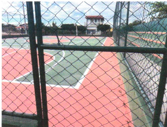
FOTO 04 - ALAMBRADO PARA QUADRA POLIESPORTIVA, ESTRUTURADO POR TUBOS DE ACO GALVANIZADO, (MONTANTES COM DIAMETRO 2", TRAVESSAS E ESCORAS COM DIÂMETRO 1 ¼ ), COM TELA DE ARAME GALVANIZADO, FIO 10 BWG E MALHA
