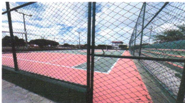
FOTO 01 - ALAMBRADO PARA QUADRA POLIESPORTIVA, ESTRUTURADO POR TUBOS DE AÇO GALVANIZADO, (MONTANTES COM DIÂMETRO 2", TRAVESSAS E ESCORAS COM DIÂMETRO 1 1/4"), COM TELA DE ARAME GALVANIZADO, FIO 10 BWG E MALHA
