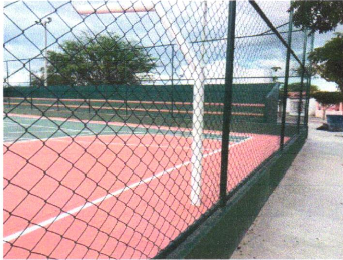
FOTO 03 - ALAMBRADO PARA QUADRA POLIESPORTIVA, ESTRUTURADO POR TUBOS DE ACO GALVANIZADO, (MONTANTES COM DIAMETRO 2", TRAVESSAS E ESCORAS COM DIÂMETRO 1 ¼ ), COM TELA DE ARAME GALVANIZADO, FIO 10 BWG E MALHA
